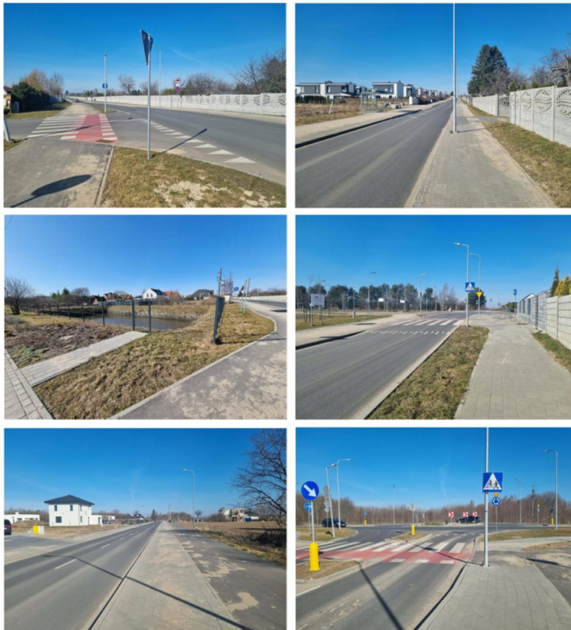
przebudowa ulic Banacha i Grechuty - stan po zakończeniu zadania w 2025 r.
