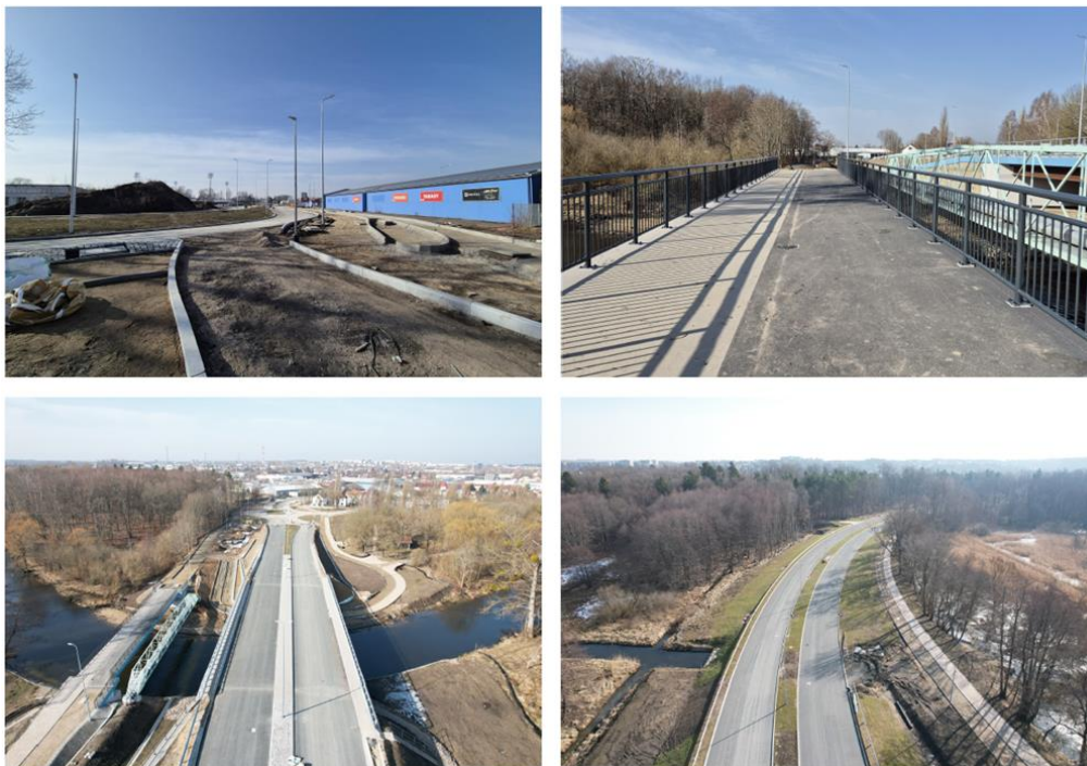
budowa południowego odcinka ringu w 2025 r.
