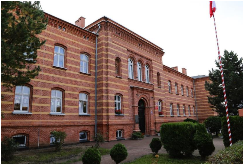
elewacja SP nr 1 w Słupsku po zakończeniu prac konserwatorskich
