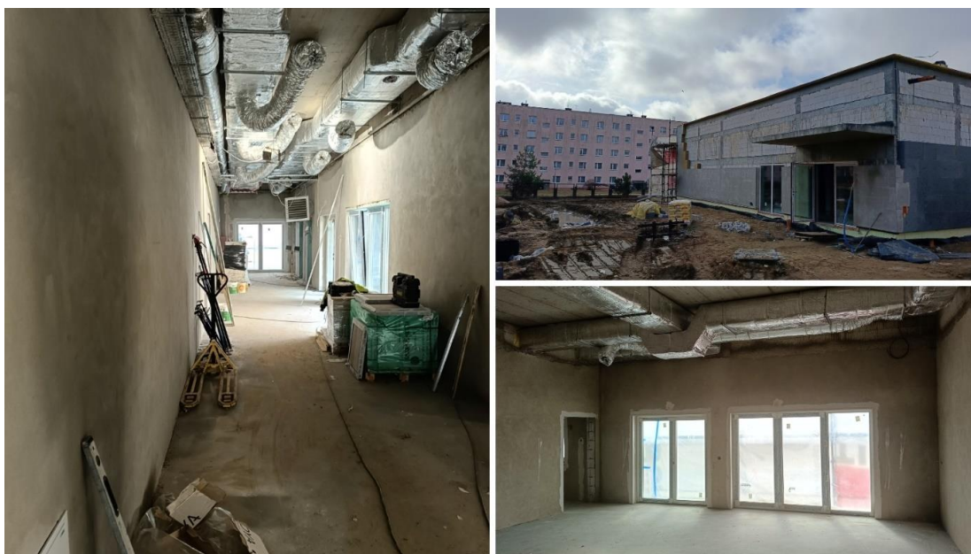
rozbudowa żłobka przy ul. Andersa 4 w Słupsku - w trakcie realizacji prac w 2025 r.
