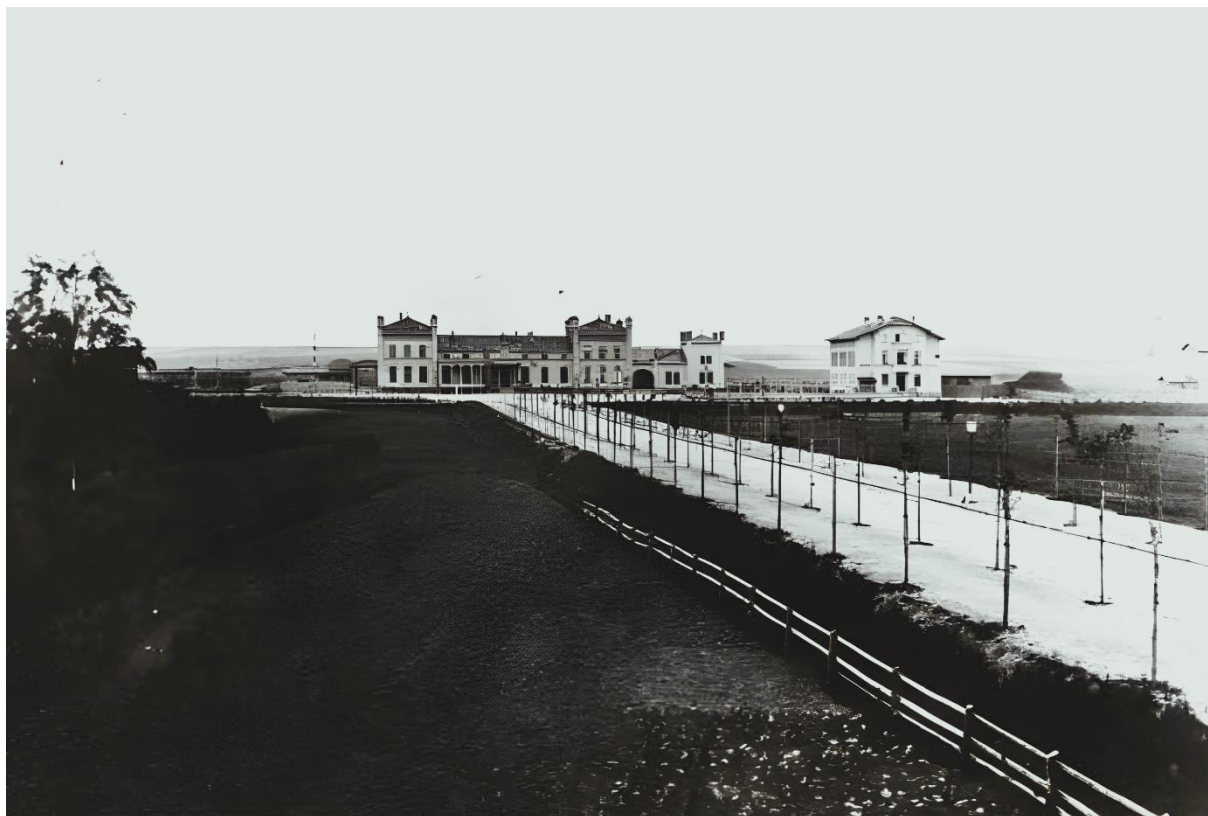
Fot. 1. Fotografia przedstawiająca nowo wytyczoną ulicę Dworcową, w kierunku dworca kolejowego, lata 70 XIX w.
