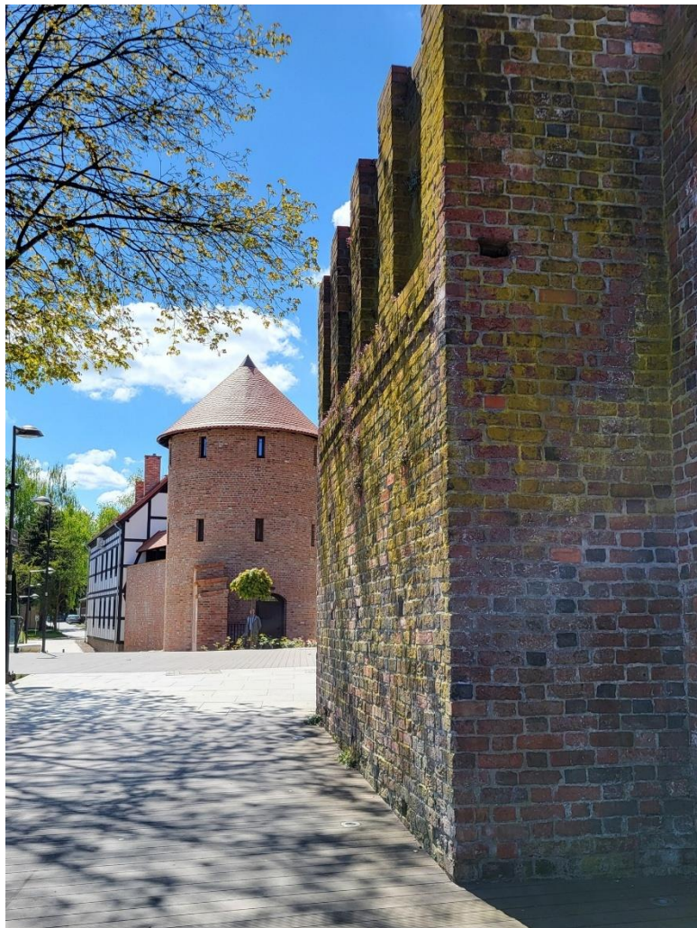
Fot. 7. Baszta i budynek przymurny
