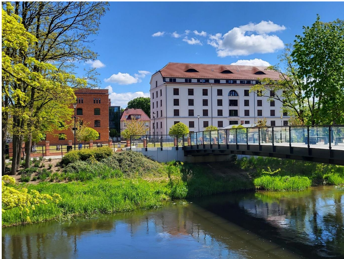
Fot. 2. Kładka piesza nad Stupią
