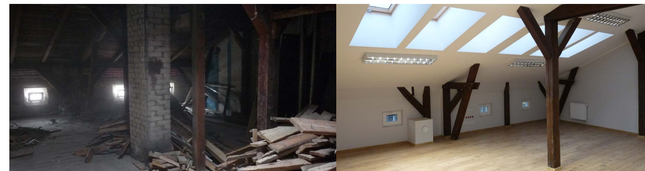
Dom Start - upów przed i po remoncie
