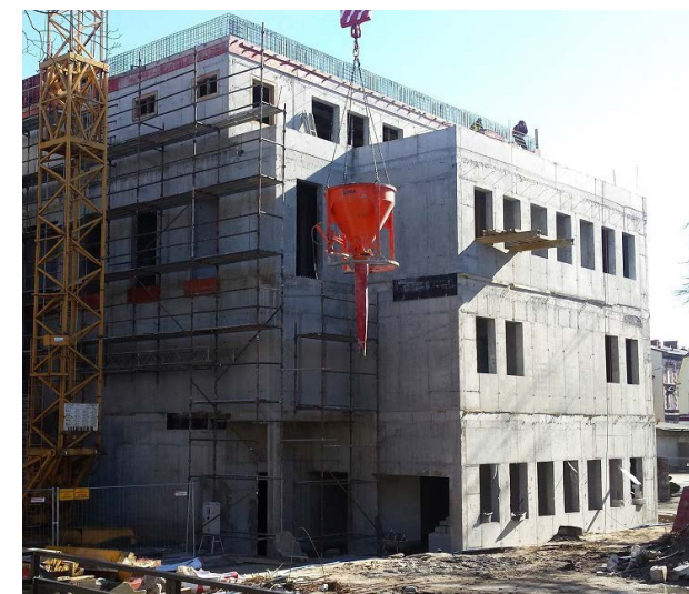
Budowa Centrum Inicjatyw Społecznych i Artystycznych
